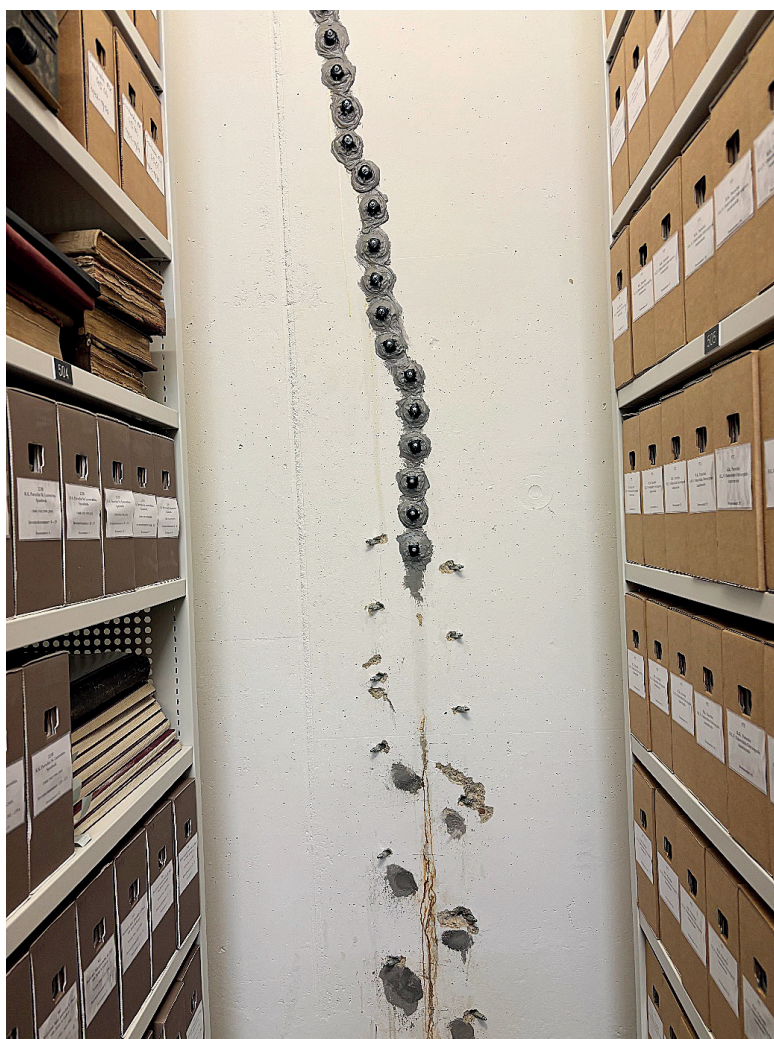
Reparatiewerkzaamheden aan de scheuren in het archiefdepot. Dit is later in het jaar netjes afgewerkt.
